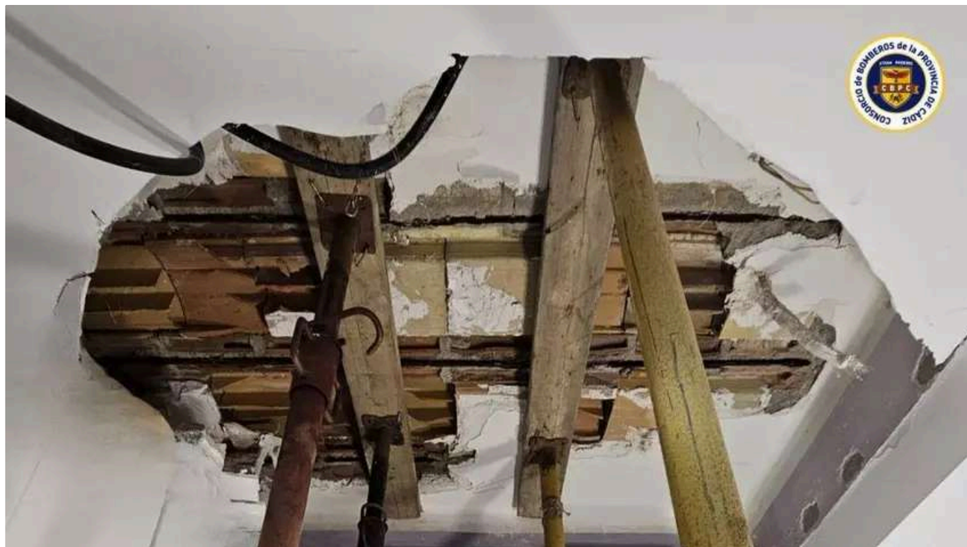
Los bomberos apuntalan una vivienda tras el derrumbe de otro techo en Cádiz
